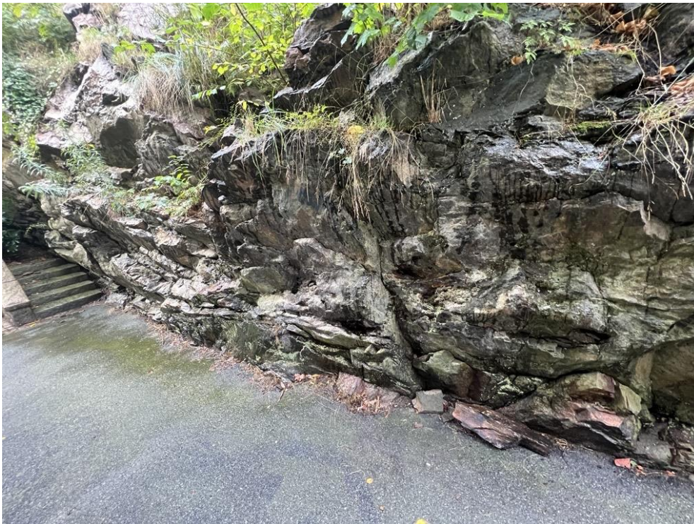
Figur 20: Bild tagen under fältbesök 16/9-2025. Bilden illustrerar bergskärningen som återfinns vid Rosengatan.
