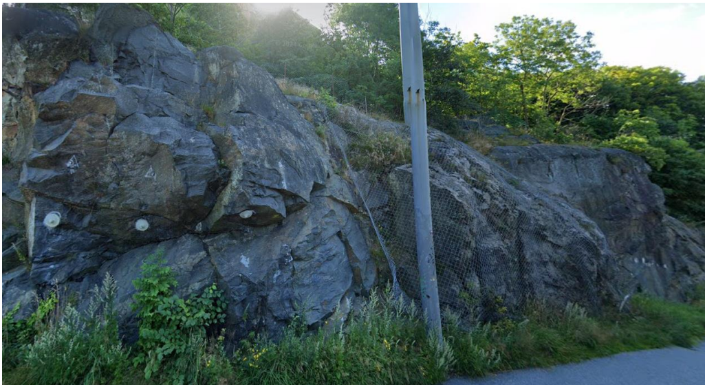
Figur 17: Bilden illustrerar delar av bergskärningen vid Fjällgatan. © Google Maps.
