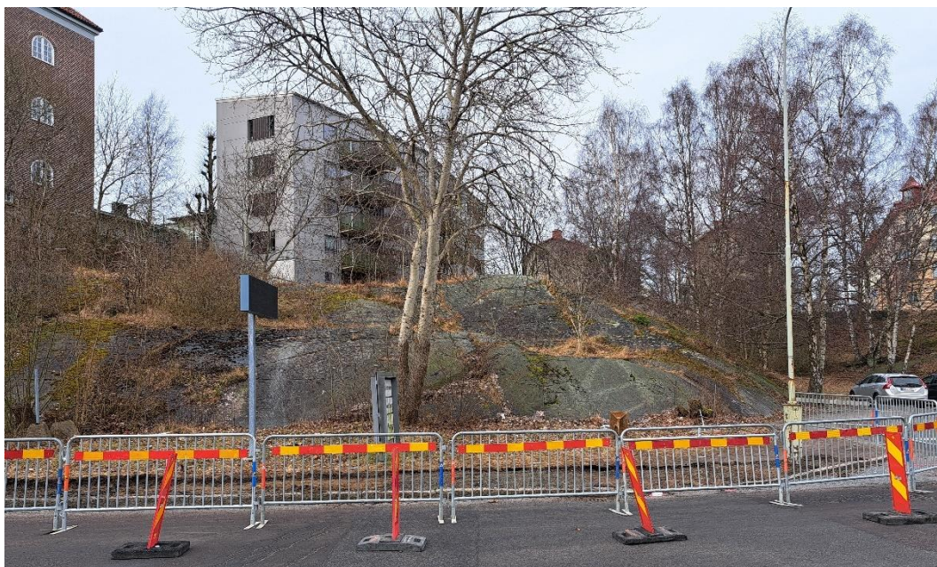
Bilaga 1: Berg i dagen i södra sidan. Vy från öster.
